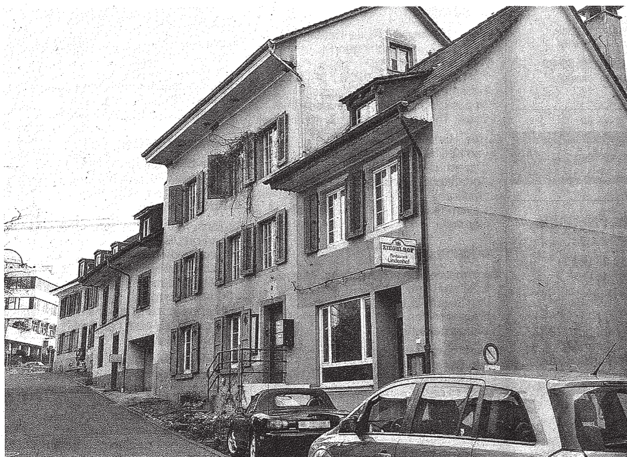
Dem Abbruch geweiht. Die alte Häuserzeile an der Lindenstrasse soll dem Neubau weichen.
